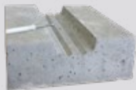
suport de beton + diblu cu șurub
